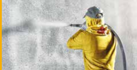
BETONSCHUTZ UND INSTANDHALTUNG
