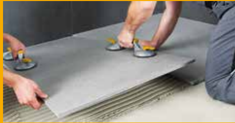
FLIESEN-, WAND- UND FUSSBODENTECHNIK
