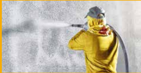
BETONSCHUTZ UND INSTANDHALTUNG
